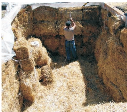
Isolerende halmballer placeres i udgravningen under drivhuset.
