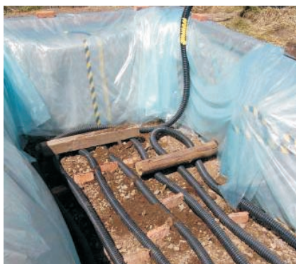
Rør til varm luft lægges i 5 lag med grus og sten imellem.
