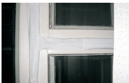
Vinduer tætnes med papir, nov. 2009.
