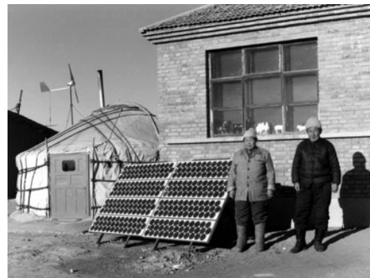
Et 500 watt kombineret solcelle- og vind-generator i Indre Mongoli.
