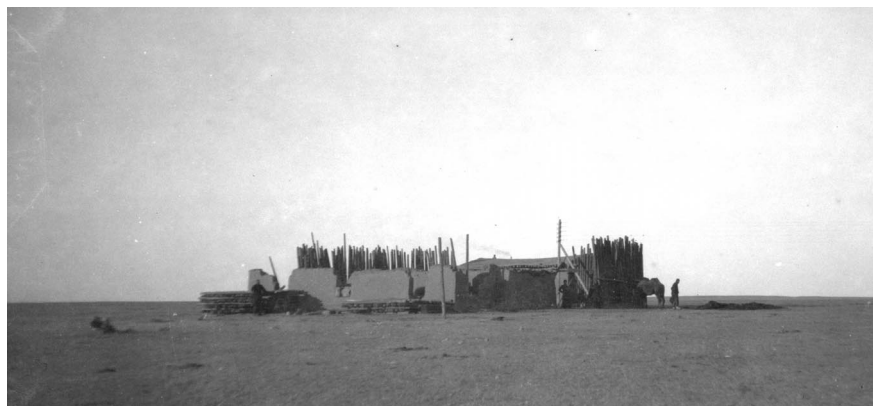
Erhlien Telegrafstation, 29. okt. 1921.
