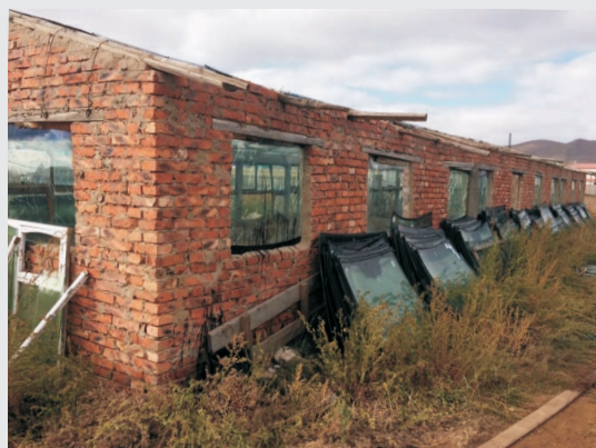
Erdenebats originale idé med at bruge ødelagte bilfor- ruder til sine drivhuse giver ikke blot lave byggeudgif- ter, men giver også et større udbytte end drivhuse af plast.
