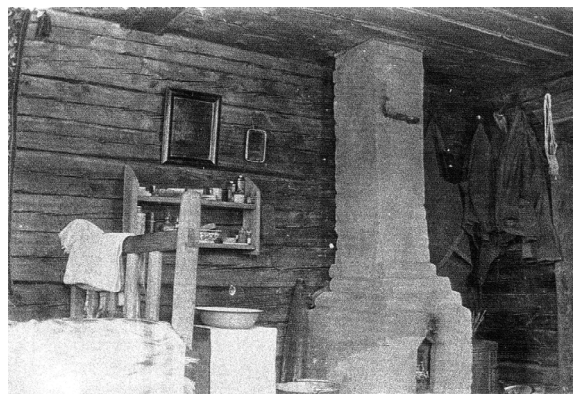
Den murede varmeovn.
