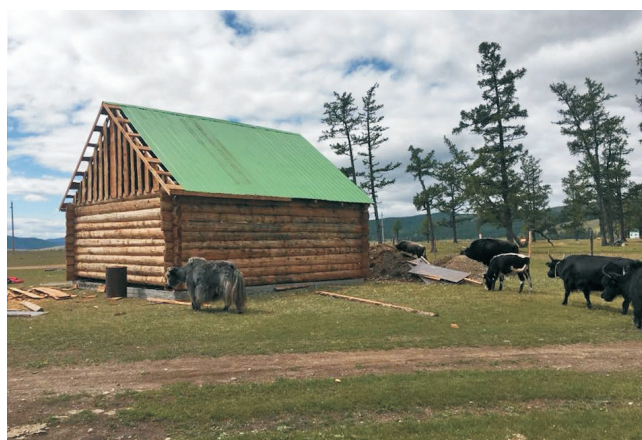
Det første hus blev opført på det dårligt udførte fundament og måtte flyttes.
