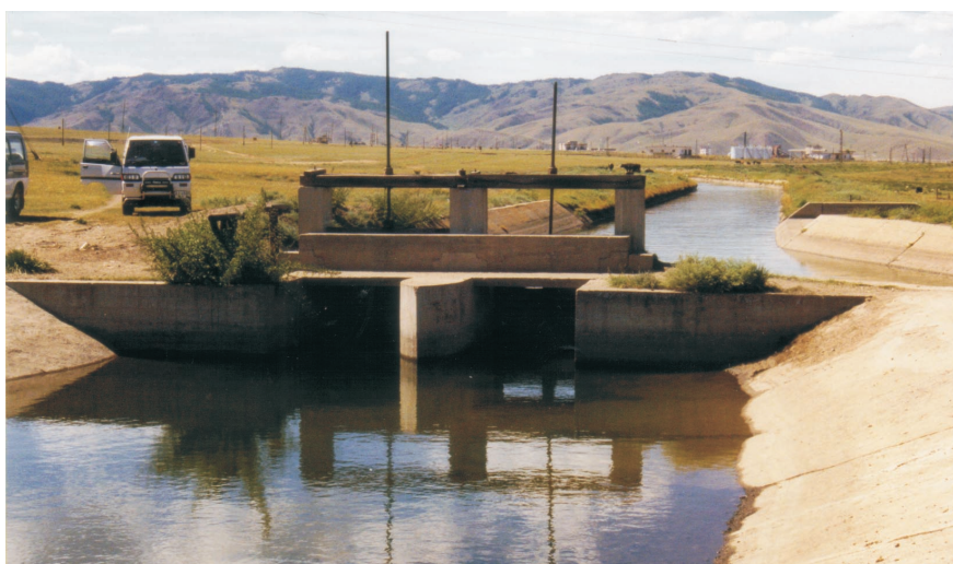
Kanalerne i et tilsvarende vandkraftanlæg af typen 'run-off-the-river' bygget af kineserne i 1960'erne i Kharkhorin.
