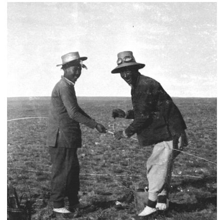
Arbejdet var stærkt specialiseret. Ét hold tog sig af kablesplejsningen.
