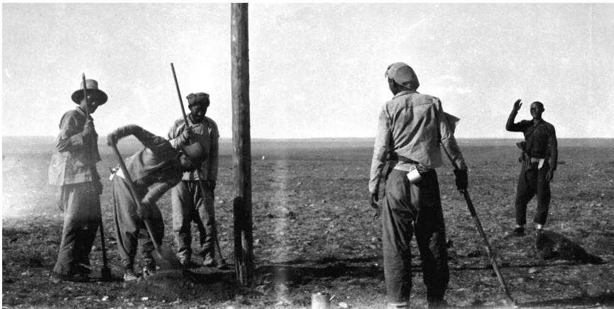
Når den nye pæl var sat i hullet, blev den rettet op og jorden kastet til af et hold på 5 mand. En rekord for antallet af rejste pæle på 1 dag var 190.
